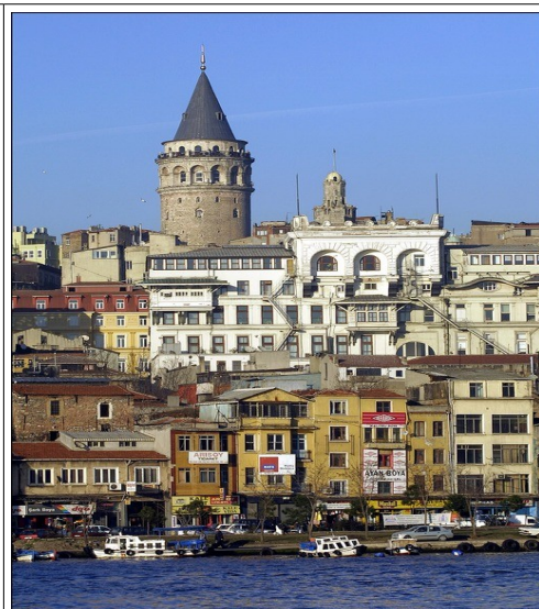
Constructions anciennes sur la rive européenne d'Istanbul
